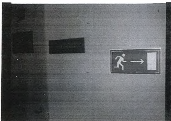
Фото № 7 – пути эвакуации
