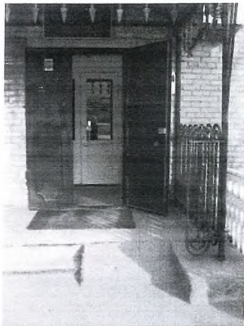
Фото № 2 – наружный пандус и входная дверь
